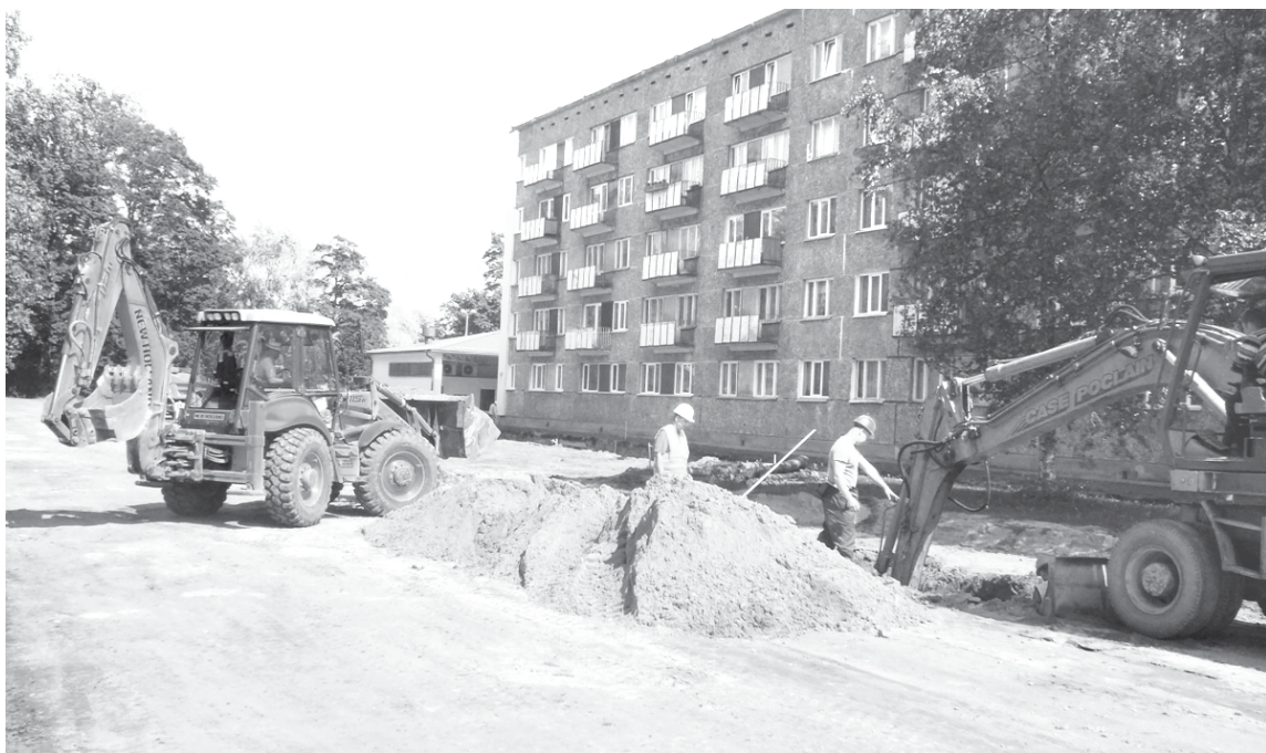
Bērzu ielā notiek lietus ūdens kanalizācijas izbūves darbi Evitas Aplokas foto
